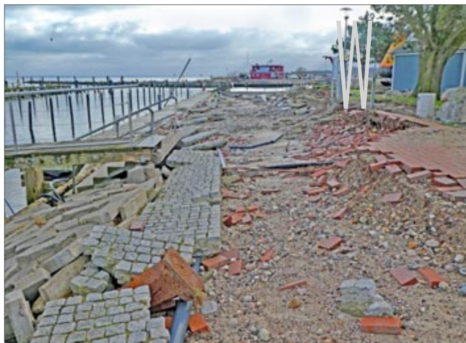
Nicht nur Brücken und Stege wurden durch die Wellen zerstört, sondern auch Uferbefestigung und Promenaden.
